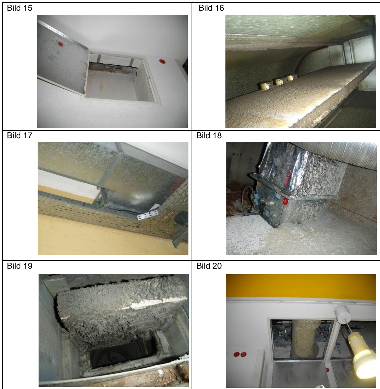
Abbildung 4: Beispiele für unzugängliche / nicht inspizierbare BSK – Revisionsdeckel kann nicht geöffnet werden bzw. Klappe ist stark verschmutzt
